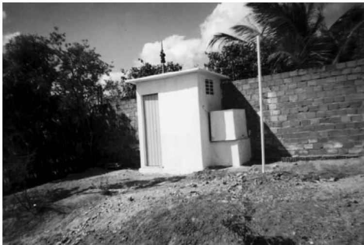
Privada com Fossa Absorvente
